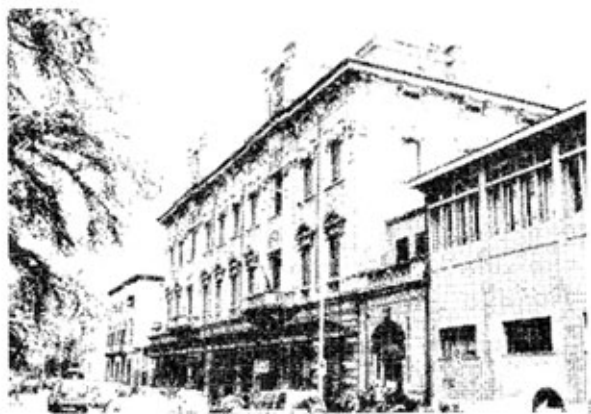
L'istituto Pertini in via Cavour
